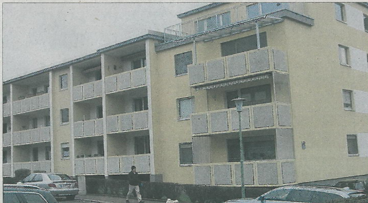
In den ehemaligen Räumen der GBW sind drei neue Wohnungen entstanden. Einziehen können Mieter mit Berechtigungsschein. (Foto: Rasche)
