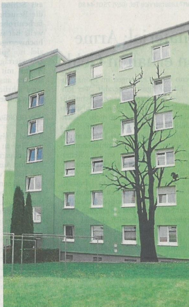
214 000 Euro investierte die GBW in dieses Mehrfamilienhaus, das bei der Renovierung auch gleich einen neuen Anstrich bekam. Foto: Privat
